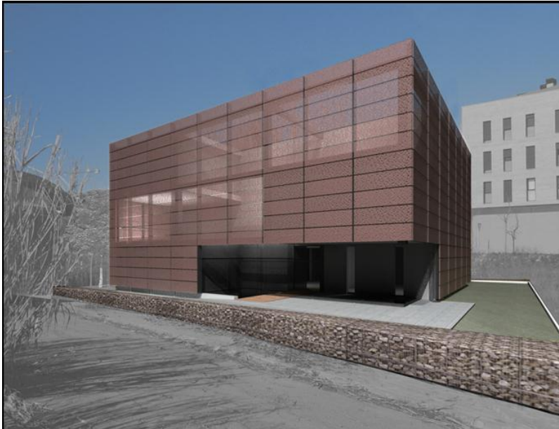
Edificio del Instituto Geológico de Catalunya
