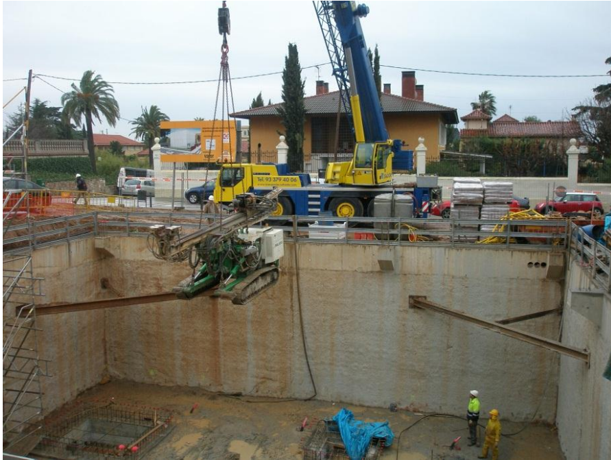
Obras en la clínica Cefer
