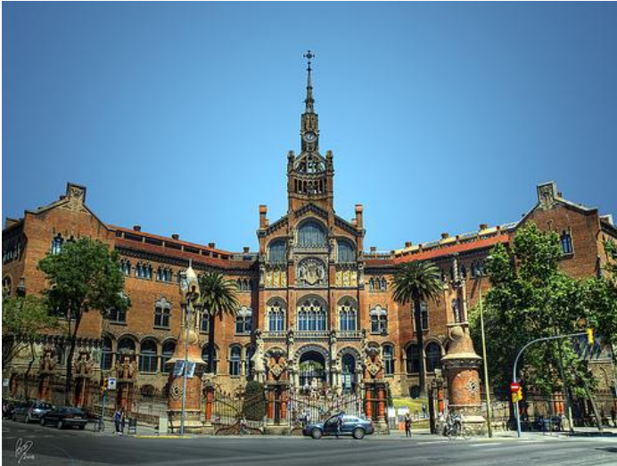
Edificio Administración, Hospital de Sant Pau
