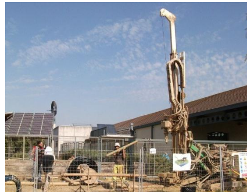
Realizando perforaciones verticales
