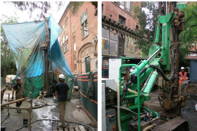
Ejecución perforaciones edificio Sant Jordi
