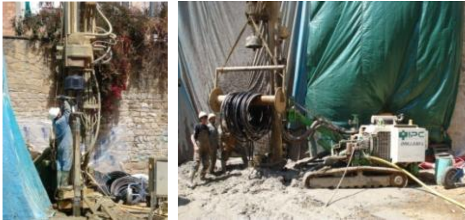
Realización perforaciones verticales
