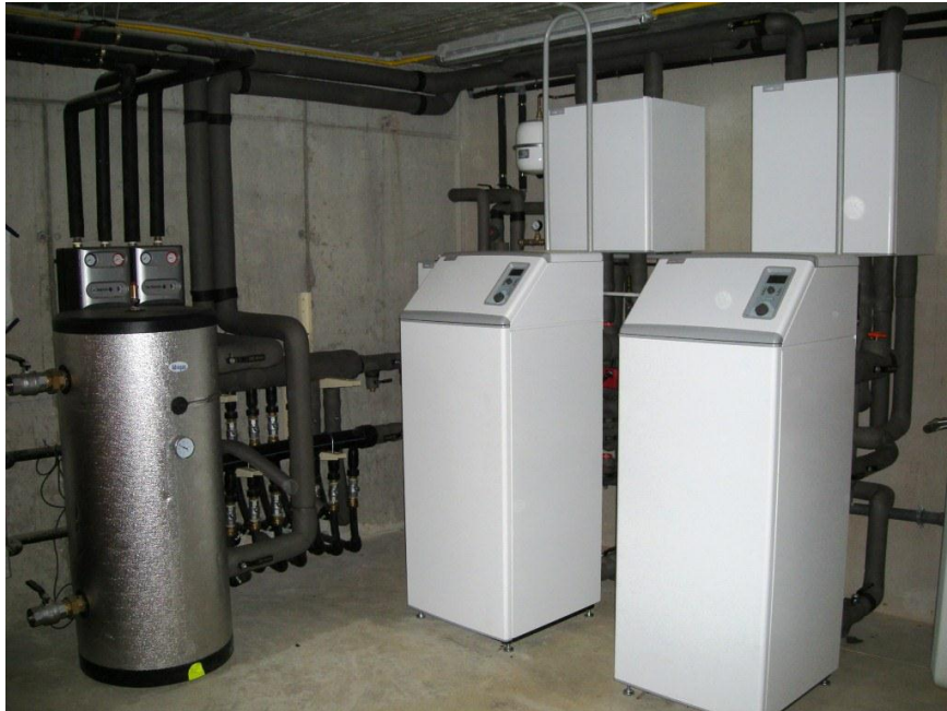
Edificio y sala de máquinas
