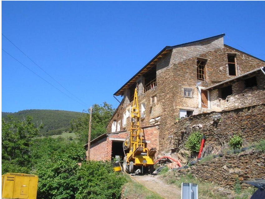
Imagen exterior hostel rural, con máquina de perforación
