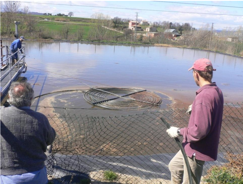
Colocación del colector en balsa de purines
