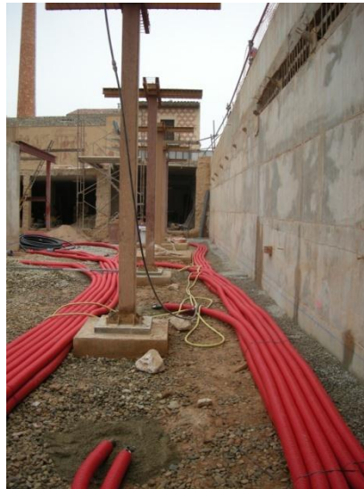
Museo de la Vida Rural, 2009, instalación de tubos
