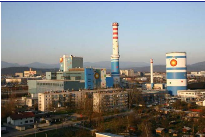
Planta de cogeneración en industria química Delfzijl - Holanda
