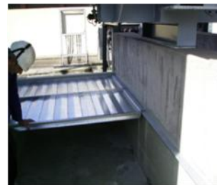
Instalación del sistema MX cortafuego
