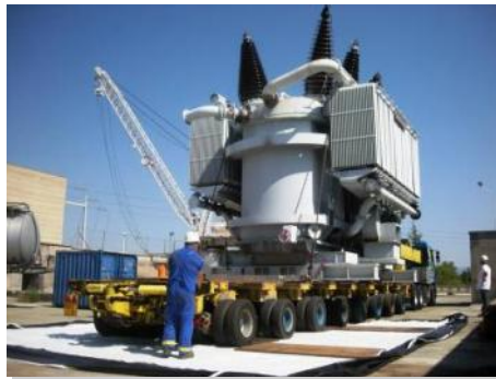
5 - Rodamiento o instalacion del Trafo
