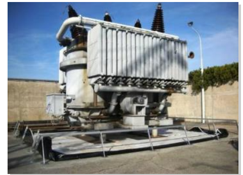
6 - Montaje del cubeto
