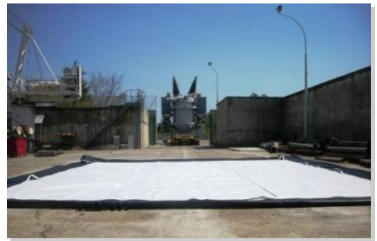
3 - Colocacion del geotextil
