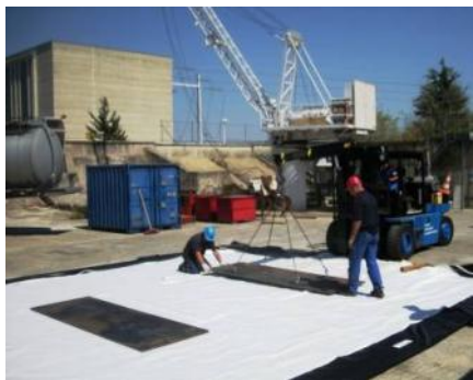
4 - Colocacion de placas de reparticion de cargas
