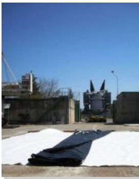
1 - Preparacion del suelo
