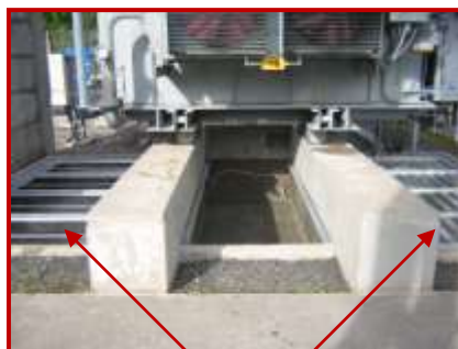
Instalación del sistema MX cortafuego
