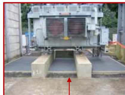
Colocación de los enrejados
