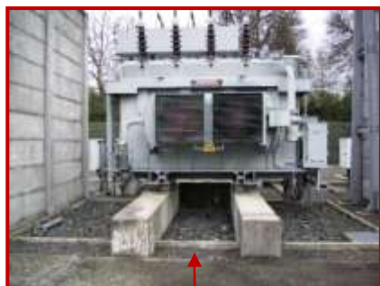
Eliminación de las piedras
