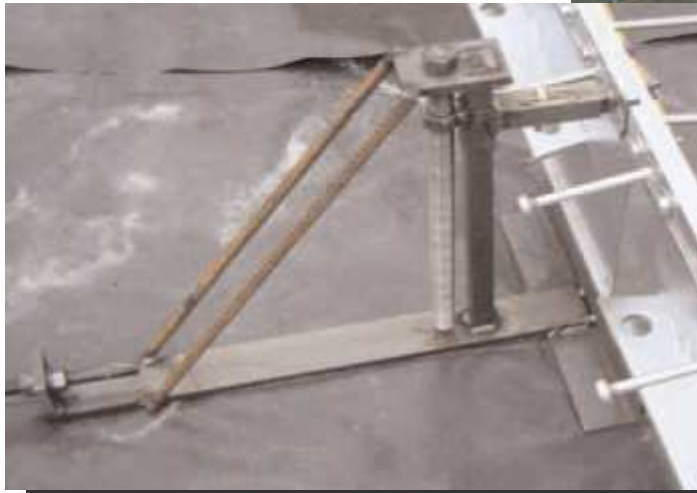
Control de la alineación y nivelación.
