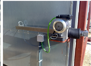
Accionament per a moure la façana
