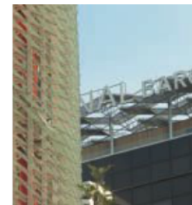
Captadors solars integrats en la façana
