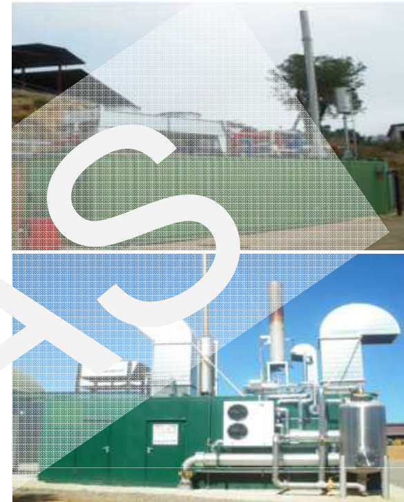
Motors de cogeneració d'APERGAS (planta de 500kW i 250kW)
