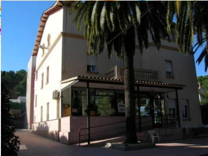
Cas 1: Terciari Residència tercera edat Les Fonts, sin gestió energètica (Terrassa)
