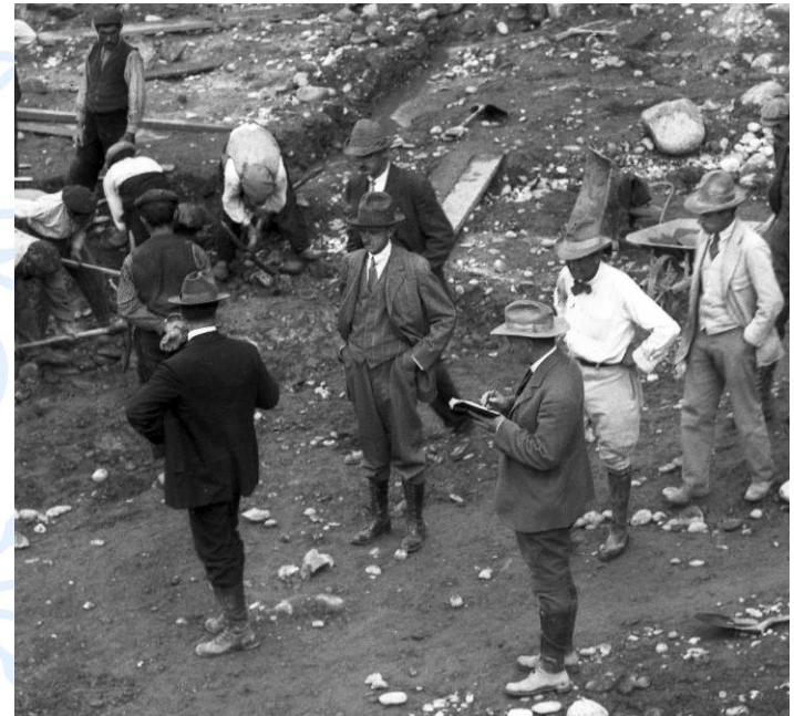
Pearson (al centre) en una visita d'obres al Pallars
