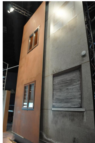
Panell de formigó armat de 700 x 250 x 3 cm de gruix, fabricat en una única peça
